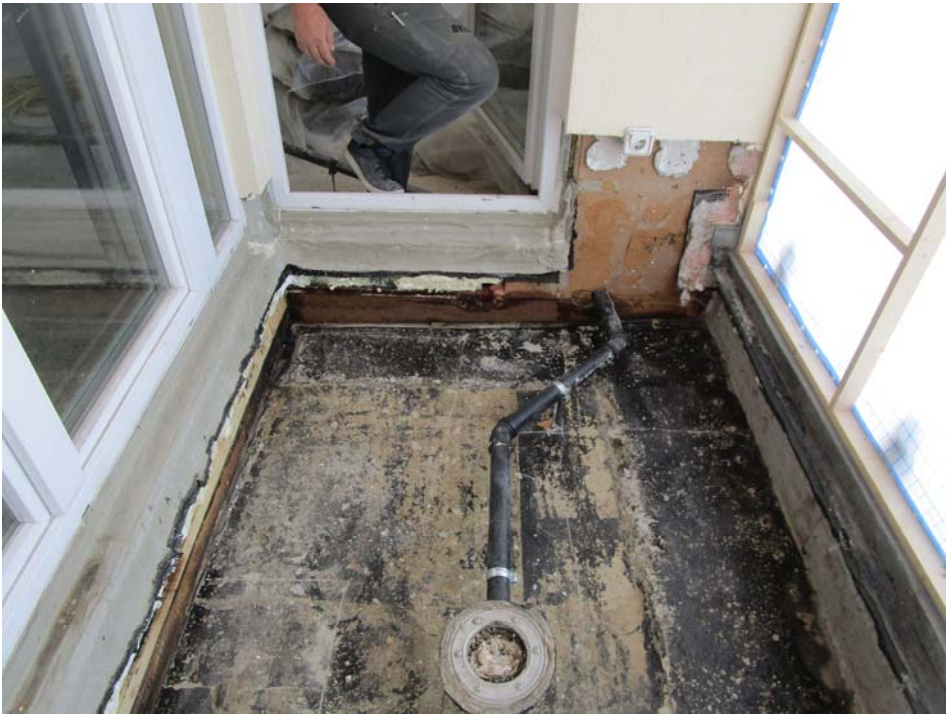
Einbindung von Leitungen
