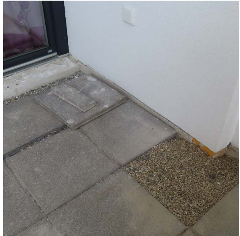
Sockelabschluss WDVS in Arbeit 1
