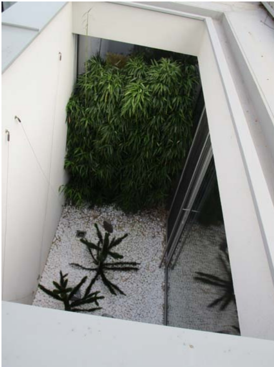
Bambus (wurzelfeste Folie erf.)
