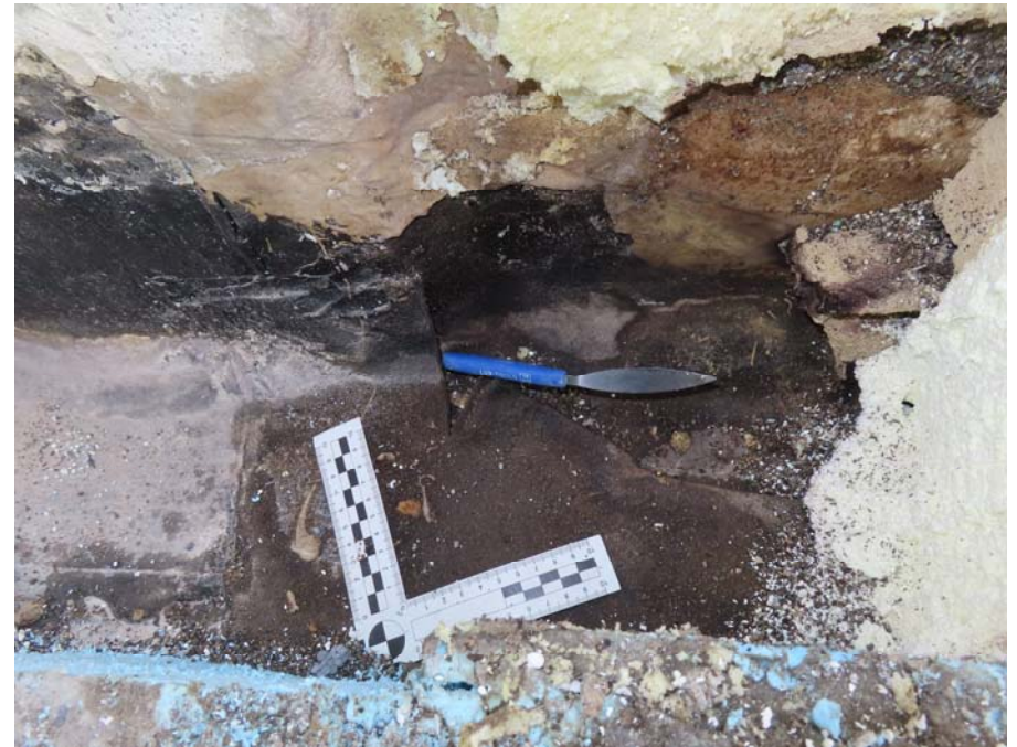
Undichtheit Abdichtung/ WDVS/ Türstock 3
