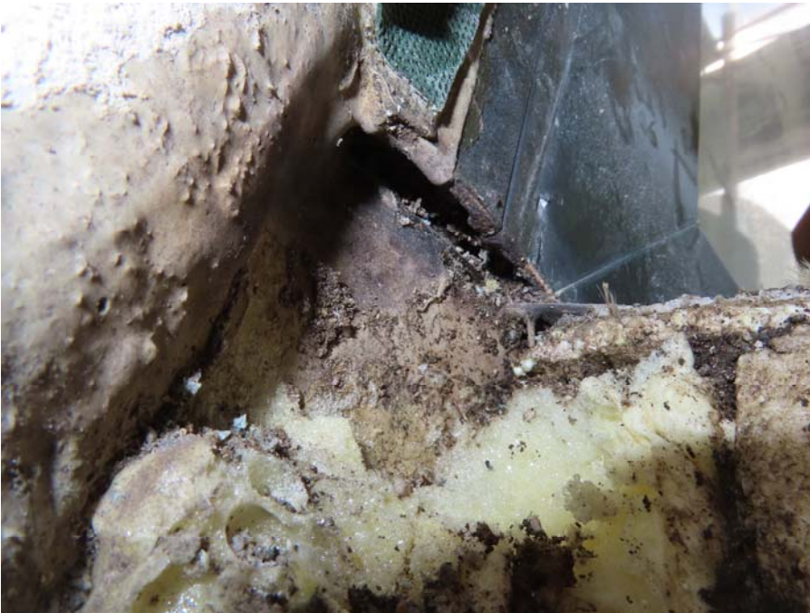
Undichtheit Abdichtung/ WDVS/ Türstock 2
