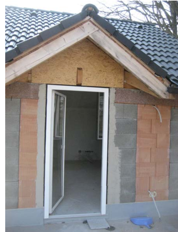
Türstaffel/ Hochzug (wie soll hier Terrassenaufbau funktionieren ?)
