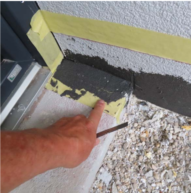
Sockelabschluss WDVS in Arbeit 2
