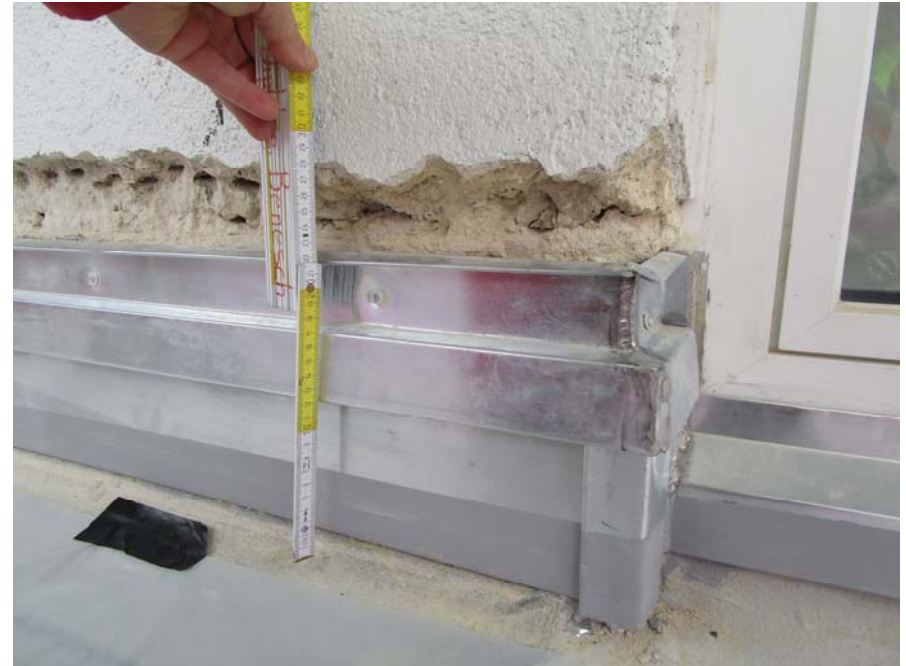
Hochzug/ spenglergmäßiger Abdichtungsschutz
