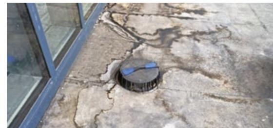
Rückstände auf der Abdichtungsfläche lassen auf Wasserpfützenbildung vor dem Entwässerungsablauf schließen. Bei der Planung des Mindestgefälles im kleinflächigen Quergefällebereichs ist dies nicht auszuschließen.
