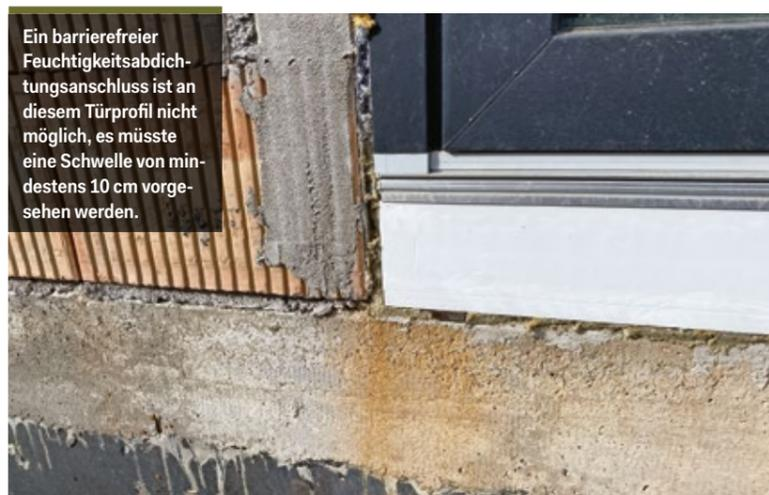
Ein barrierefreier Feuchtigkeitsabdichtungsanschluss ist an diesem Türprofil nicht möglich, es müsste eine Schwelle von mindestens 10 cm vorgehen werden.
