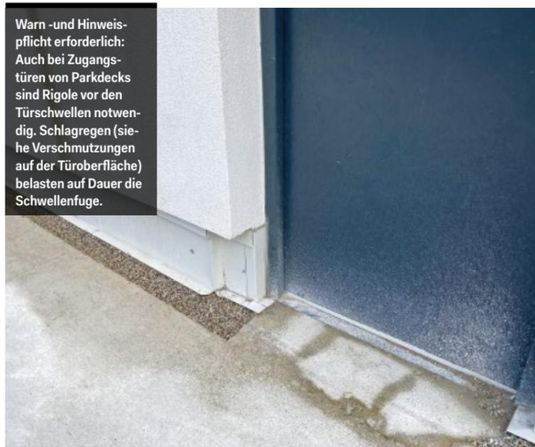
Warn- und Hinweispflicht erforderlich: Auch bei Zugangstüren von Parkdecks sind Rigole vor den Türschwellen notwendig. Schlagregen (siehe Verschmutzungen auf der Türoberfläche) belasten auf Dauer die Schwellenfuge.
