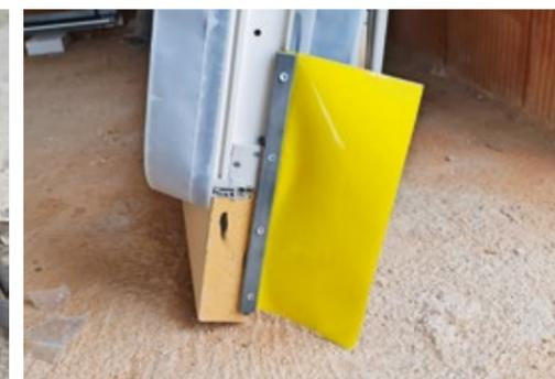
← ← Falsch: Keine Rohrdurchführungen durch das Bodeneinstandsprofil.
