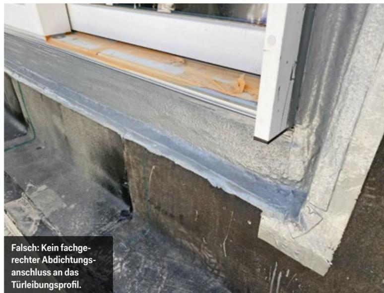
Falsch: Kein fachgerechter Abdichtungsanschluss an das Türleibungsprofil.
