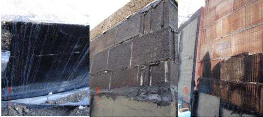
Bild links: zu glatte Betonoberfläche, Abdichtung abgerutscht
