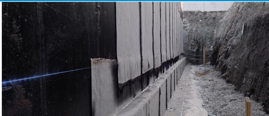
Der Tiefzug der ersten Abdichtungslage an der Fundamentbodenplatte-Stirnseite muss mind. 10 cm unter Oberkante Bodenplatte geführt werden, der Tiefzug der zweiten Abdichtungslage mind. 25 cm unter Oberkante Bodenplatte.
