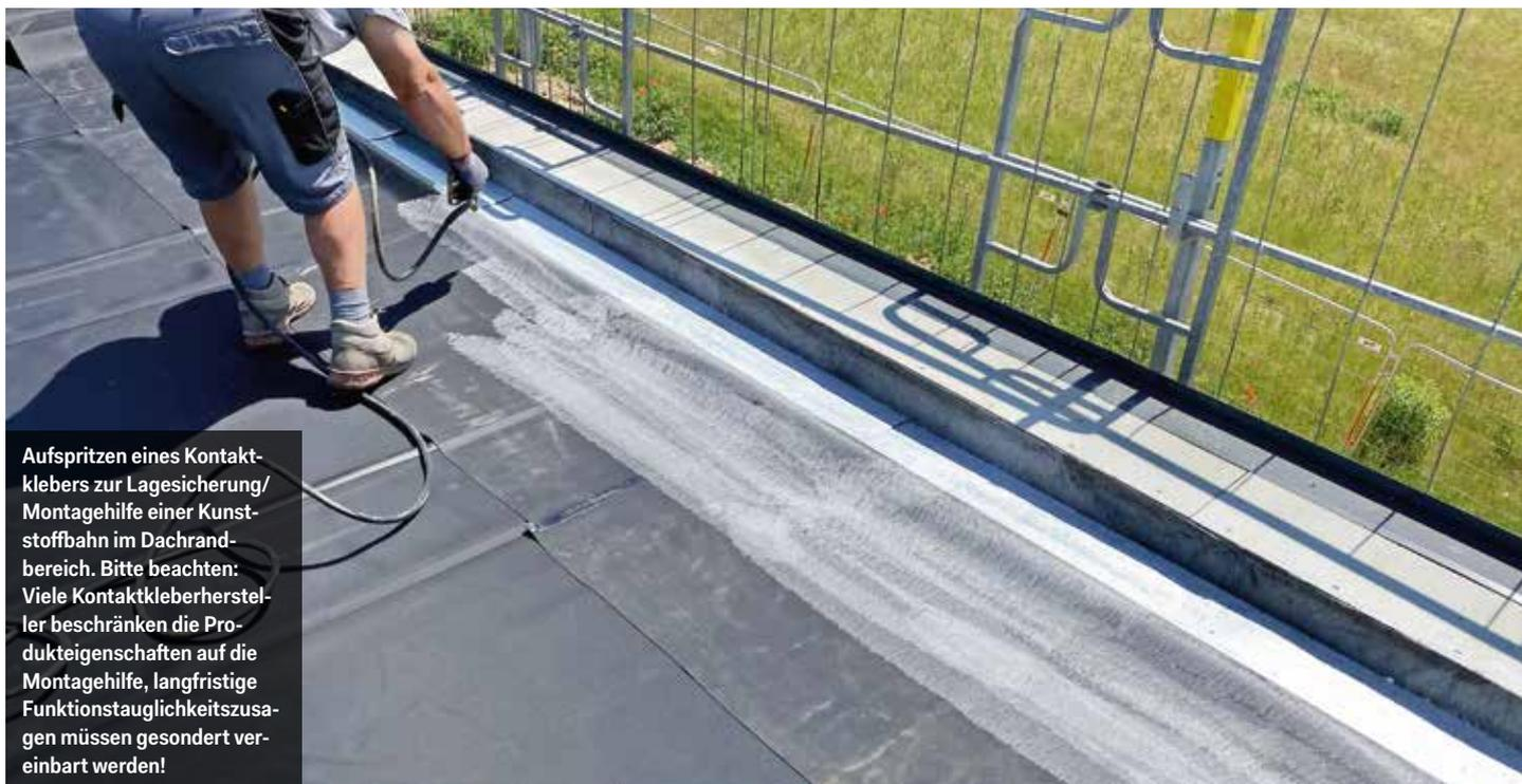
Aufspritzen eines Kontaktklebers zur Lagesicherung/ Montagehilfe einer Kunststoffbahn im Dachrandbereich. Bitte beachten: Viele Kontaktkleberhersteller beschränken die Produkteigenschaften auf die Montagehilfe, langfristige Funktionstauglichkeitszusagen müssen gesondert vereinbart werden!
