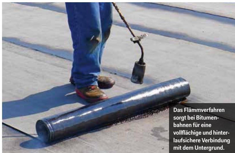
Das Flämmverfahren sorgt bei Bitumenbahnen für eine vollflächige und hinterlaufsichere Verbindung mit dem Untergrund.
