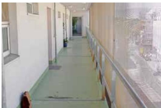
Die Beschichtung löst sich von der Betonoberfläche. Grund ist eine unzureichende Untergrundvorbereitung, das Ergebnis sind Frostschäden im Bereich der An- und Abschlüsse der Laubengang-Geländer.
