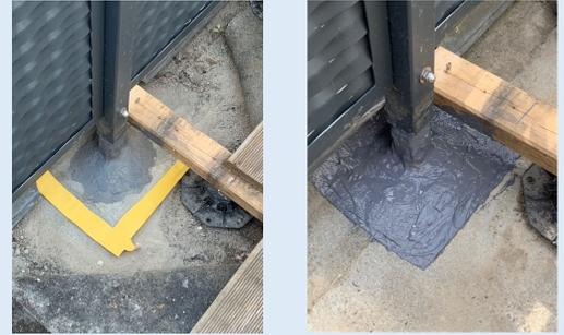
**Verschluss der Dachöffnung mit Flüssigkunststoff und Aufstauung des Wassers bis auf 7cm im Bereich der Abläufe am 5.10.2023**
