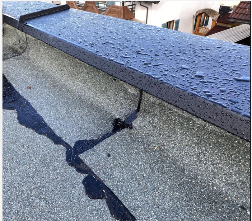
Bitumenausstritt bei 2-Lagen Polymerbitumen auf (geneigten) frei bewitterten Dächern
