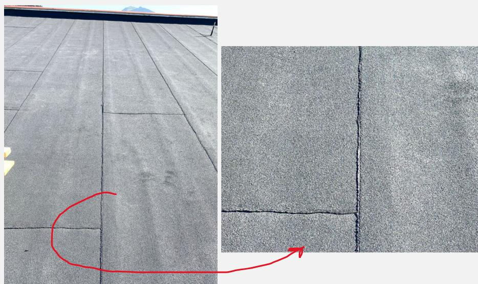
Bitumenausstritt bei 2-Lagen Polymerbitumen auf (geneigten) frei bewitterten Dächern
