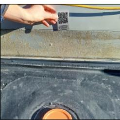
Die Positionsplakette sollte sichtbar an der Fassade oder dem Terrassenbelag angebracht werden.
