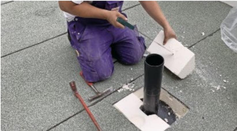
Im Zuge des nachträglichen Einbaus von Inspektionsöffnungen können auch Sensoren eingebaut werden, die über den Klimawandel im Dachschichtenaufbau Auskunft geben.
