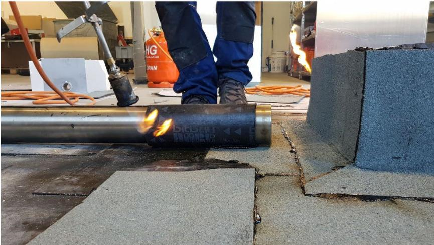
Auf der Auf-/ Abrollvorrichtung können unterschiedlich breite Bitumenbahnen (im gegenständlichen Versuch bis 100 cm Breite) und Bitumenbahnenstreifen aufgerollt und verarbeitet werden.
