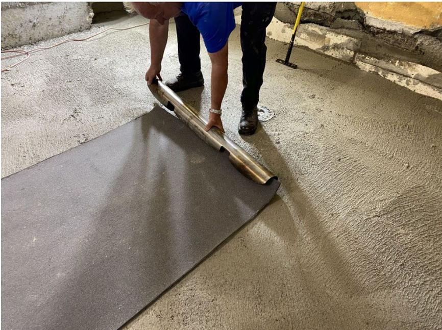
Durch Reduktion der Schrägstellung dringt die Bahnschnittkante in den Längsschnitt und in die Fixierspangen der Auf-/ Abrollvorrichtung ein.
