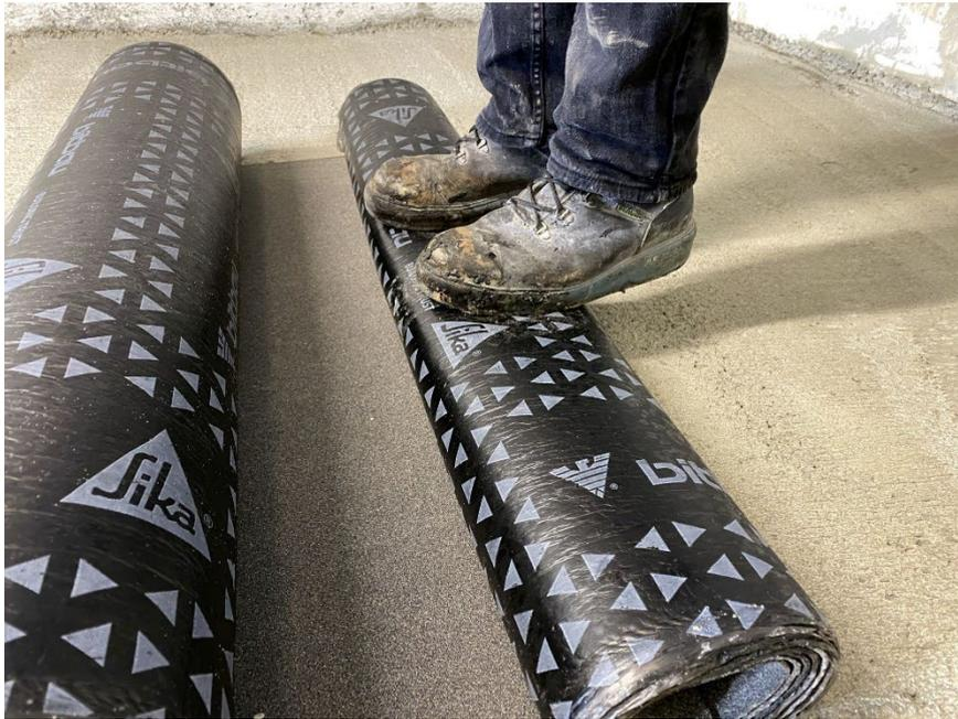
Bitumenbahnen, welche ohne Auf-/ Abrollvorrichtung aufgerollt wurden, sind verformungsinstabil.
