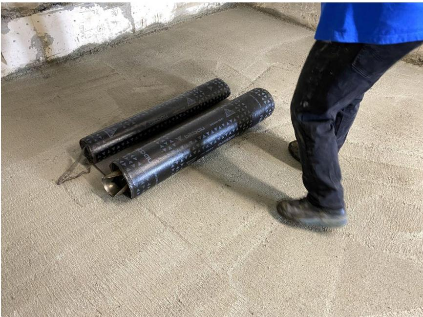
Fast vollständig aufgerollte Bitumenbahn auf der Auf-/ Abrollvorrichtung.
