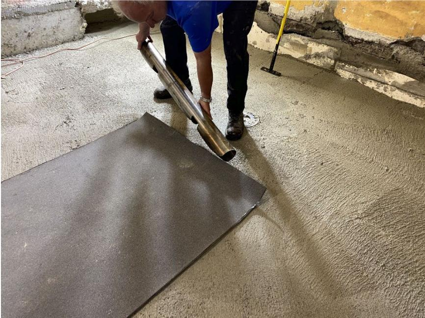
Die schräggestellte Auf-/ Abrollvorrichtung wird auf die Bitumenbahnschnittkante aufgesetzt.
