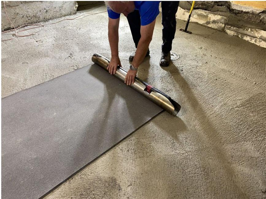
Durch eine halbe Umdrehung der Auf-/ Abrollvorrichtung wird die Bitumenbahn fixiert.
