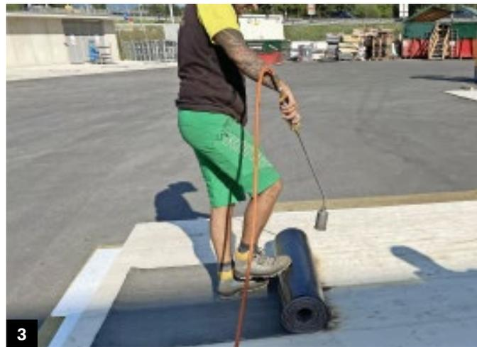
**Die Idee des einreichenden Unternehmens, das als Bauwerksabdichtungsunternehmen tagtäglich mit dem „Risiko“ konfrontiert wird, auch Flämmerarbeiten im einmal mehr oder weniger unmittlerbaren Bereich von brennbaren Stoffen durchführen zu müssen, war, einfach zu applizierende, rückstandsfreie und somit temporäre Brandschutzmaßnahmen einzusetzen.**
