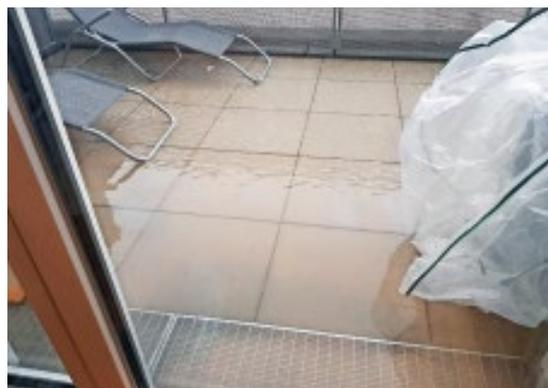
Häufiger Problem- bzw. Schadensfall: Stauwasser auf einer Terrassenfläche. Die Ursachen hier sind die zu geringe Dimensionierung der Entwässerungsbahnen und die falsche Position der Notabläufe.
