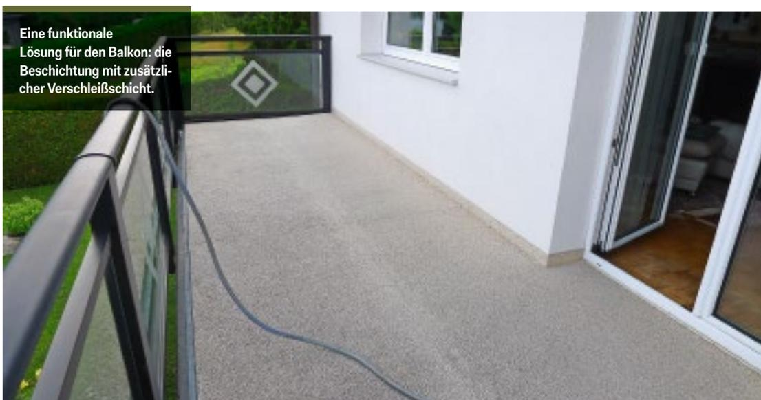
Eine funktionale Lösung für den Balkon: die Beschichtung mit zusätzlicher Verschleißschicht.
