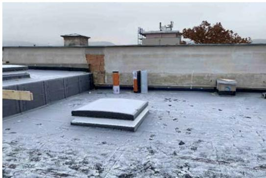
**Hauptdach (Warmdach System Bauder) intensiv begrünt Substrat "Dachgarten"**
