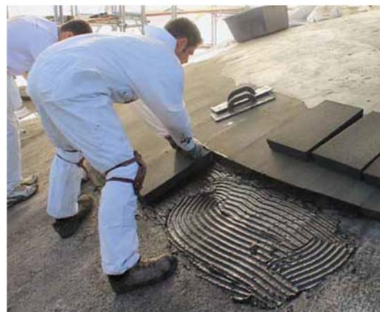
Ursprüngliche in Teer getränkte Korkdämmung und Verlegung der neuen Schaumglas-Dämmplatten, Dicke 6 cm
