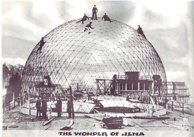
Bau der Kuppel des Planetariums 1924 in Schalenbauweise: Bewehrung (Stabnetz) für die 6 cm dicke Stahlbetonkuppel bei einem Durchmesser von 25m
