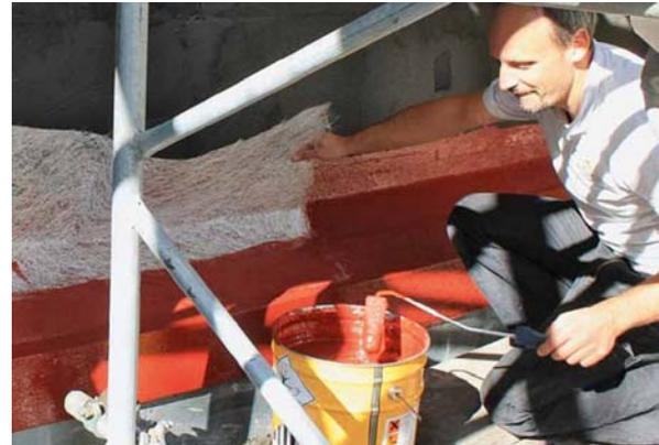
Auftragen des Flüssigkunststoffes und Einbetten einer Glasvlieseinlage
