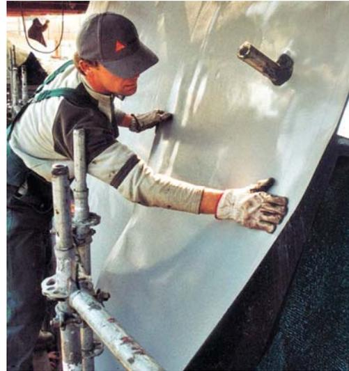
Aufbau oberhalb der Schaumglas-Platten: Bitumendeckabstrich, erste Lage Bitumenabdichtungsbahn, Kaltselfstklebebahn als wasserführende Schicht
