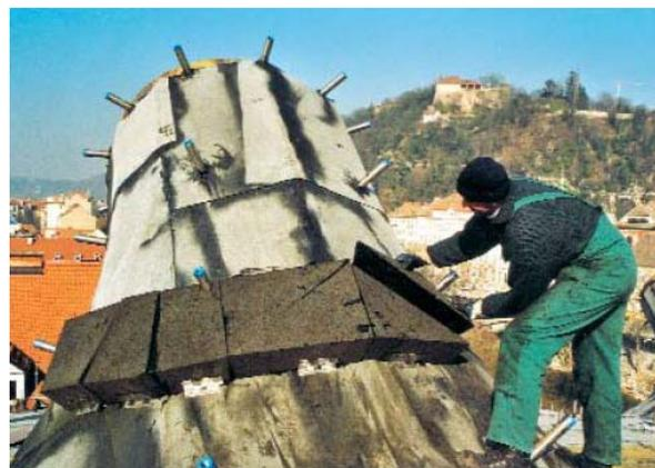
Anpassung der Schaumglas-Platten an die Dachform mittels dreiecks- oder trapezförmiger Keile
