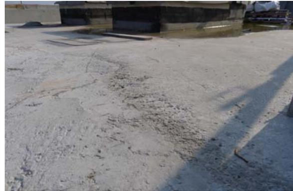
**Risse und erhöhte Rauheit an der Oberfläche des Untergrundes !**
