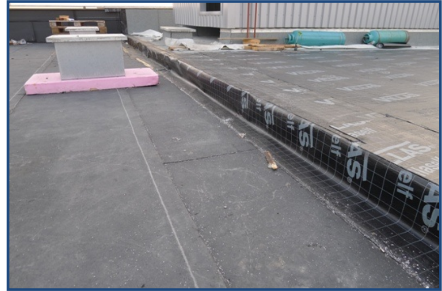
Skizze 4 Abschottung mit Klebeband
