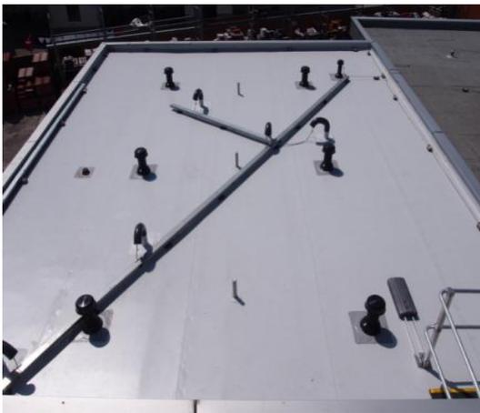
Im Vordergrund der Versuchsdurchführung stand sowohl die Verifizierung der Funktionsfähigkeit des RP als auch das Trocknungsverhalten des Einbau-Sets (Dachlüfter).
