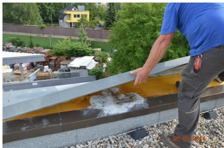
Kondensat zerstört die Unterkonstruktion und die Attikaabdeckung
