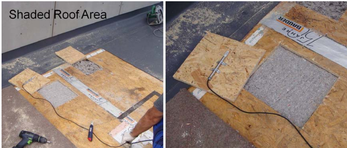
Abbildung 2: Montage der Messsensoren im beschatteten Dachbereich
