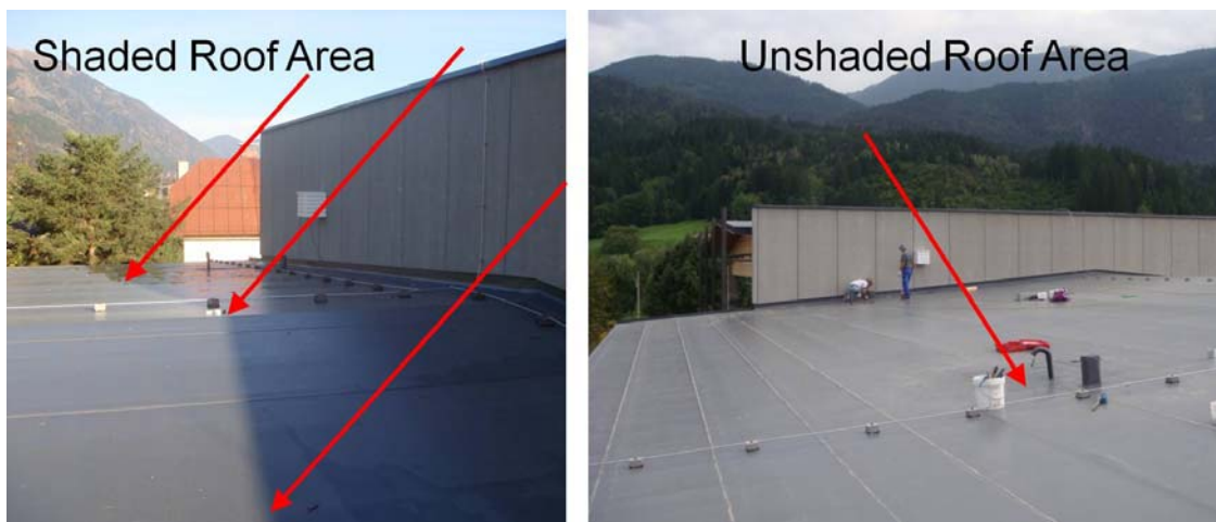
Abbildung 1: In-Situ Messungen an Dachkonstruktionen eines Produktionsgebäudes
