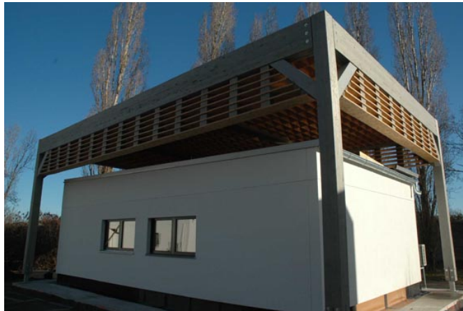
Abbildung 3: Südwestansicht des bauphysikalischen Forschungshauses B mit überspannendem Beschattungselement und darin eingelegtem Gitterrost aus OSB-Plattenstreifen.
