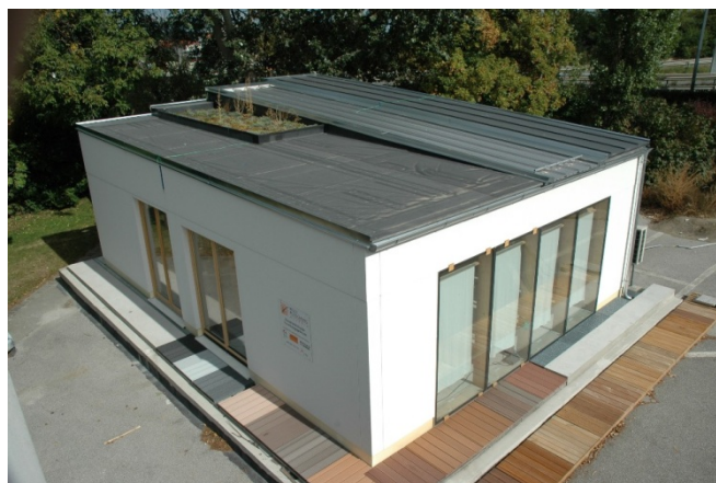
Abbildung 2: Südwestansicht des bauphysikalischen Forschungshauses A.
