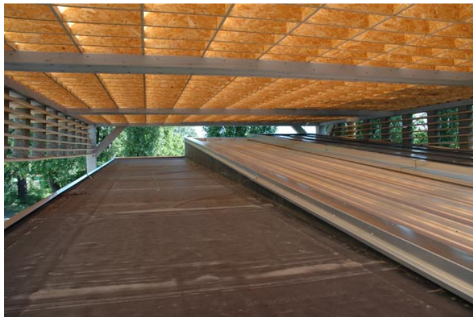
Abbildung 4: Dachansicht des Forschungshauses B mit überspannendem Gitterrost aus OSB-Plattenstreifen zur Simulation einer Beschattung.
