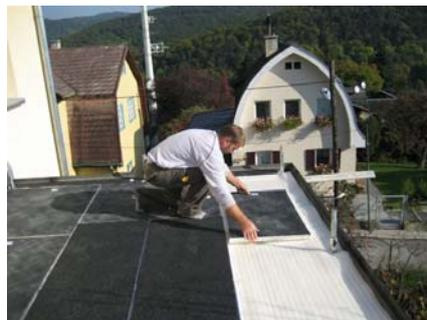
... es werden die **Vacupor® RP1** Dämmplatten mit den werksseitig aufkaschierten Gummigranulatmatten verlegt, denn die **Dämmung** bietet **zugleich** auch die **Schutzfunktion**
