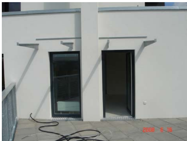
Vordach mit seitlichem Überstand
