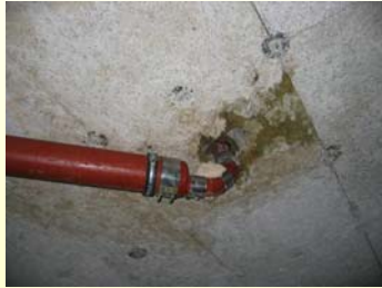
Garage – Nässeschäden durch verstopfte Leitung
