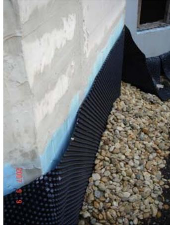
9. Schutzschichten (Noppenbahnen), Perimeterdämmung (XPS)
