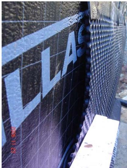
9. Schutzschichten (Noppenbahnen), Perimeterdämmung (XPS)
