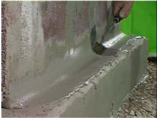
Hohlkehle zwischen Fundamentplatte und aufgehendem Mauerwerk
