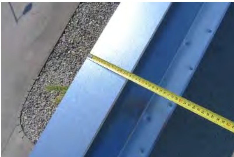
Obere Breite des gekanteten Blechstreifens ~15 cm.
