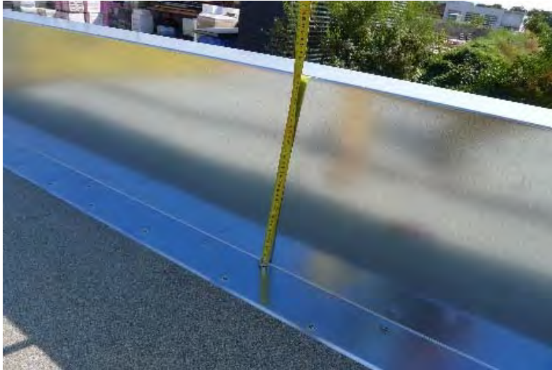
Höhe des Z-förmig gekanteten Metallprofils 40 cm.
