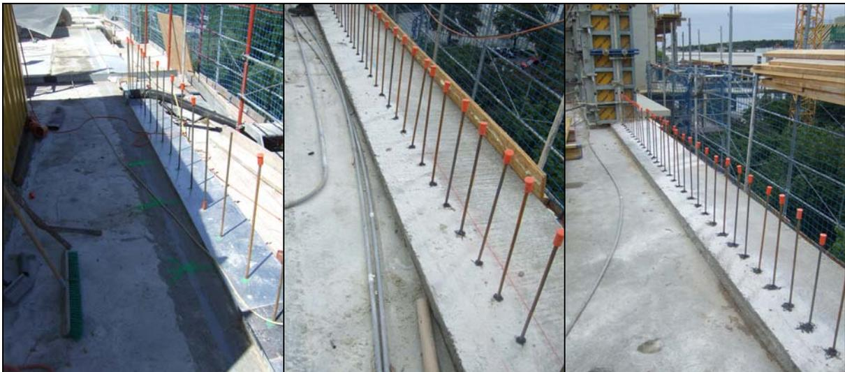
**Abb. 14:** Beispiele für Stecker für Hohlwände, jeder Stecker separat eingedichtet
