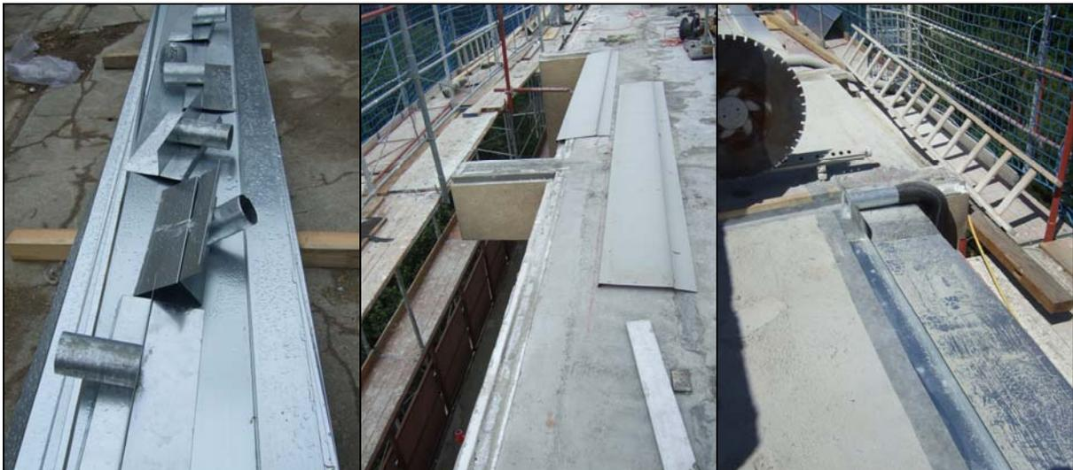
**Abb. 11:** links: Formteile und Anschlussbleche (Traufe) für Bauschutzabdichtung
