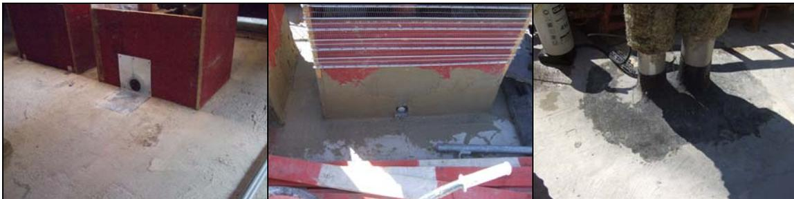
**Abb. 10:** links: Formteil Anschluss für provisorische Innenentwässerung (vor dem Aufbringen der Bauschutzabdichtung)
