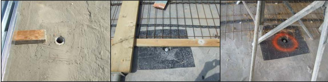
**Abb. 12:** Beispiele für provisorische Innenentwässerung (Gullys)
