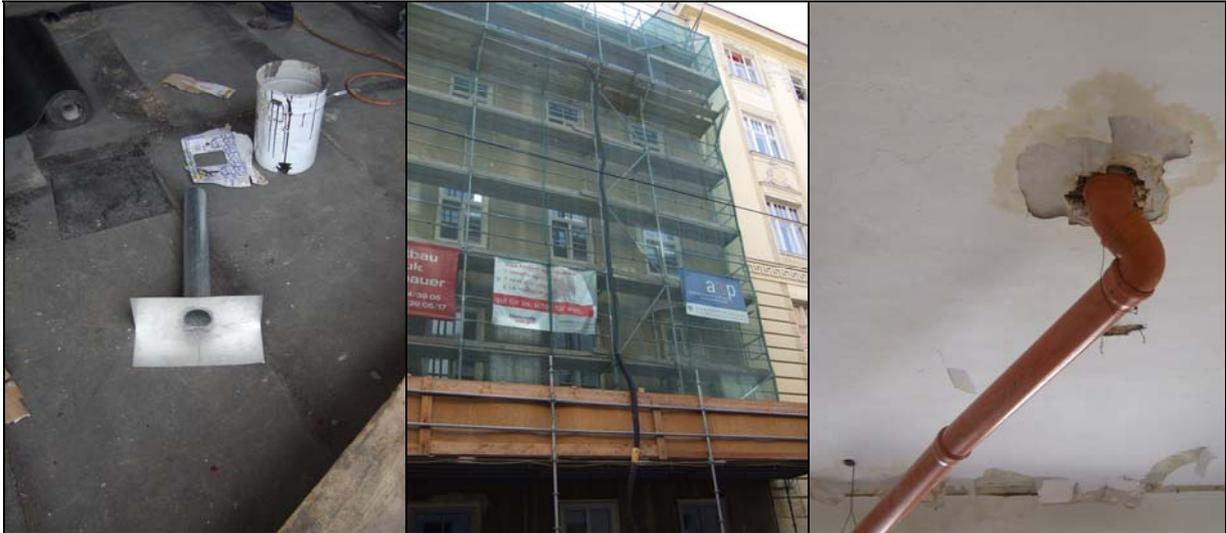
**Abb. 2:** links: Formteil für Außenentwässerung;
