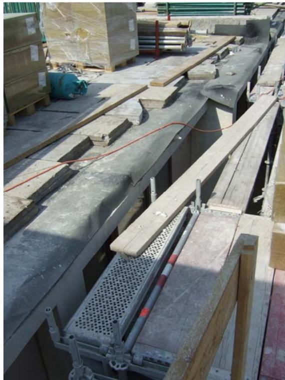
**Abb. 6:** Ergänzte Bauschutzabdichtung mit Attikabereich, Gefahr der Kondensatbildung im Anschlussbereich Außenwand/Decke in den Wintermonaten
