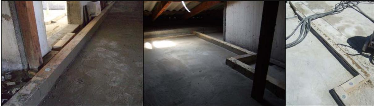
**Abb. 9:** Pfosten als provisorischer Abschluss der Bauschutzabdichtung, vor bzw. nach Abbruch Dachstuhl
