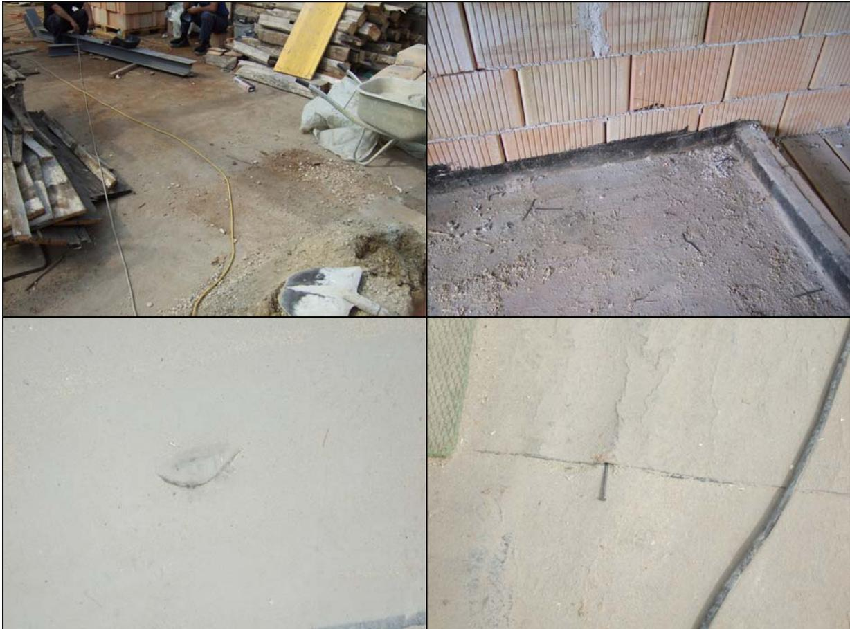
**Abb. 15:** oben: ungeschützte Bauschutzabdichtungen
