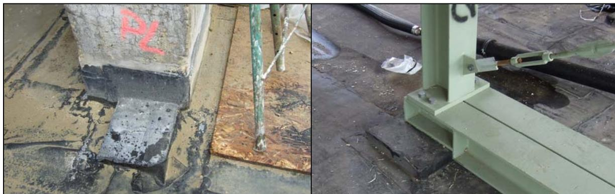
**Abb. 5:** Sockeln für Stahlstützen
