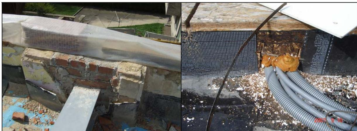
**Abb. 16:** links: Abdichtungshochzug beschädigt
