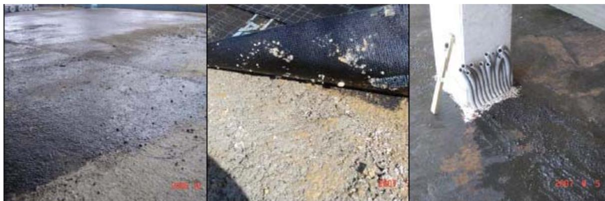
**Abbildung 2:** Untergrund bei Flächenabdichtungen: Bild links: zu raue Betonoberfläche → Glattstrich erforderlich; Bild Mitte: Untergrund sandet ab; Bild rechts: Untergrund im Bereich der Elektroleitungen zu uneben → Glattstrich erforderlich.
