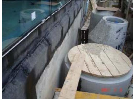
**Abbildung 5:** Abstand Schacht/Außenwand zu gering um Abdichtung normgemäß herstellen zu können
