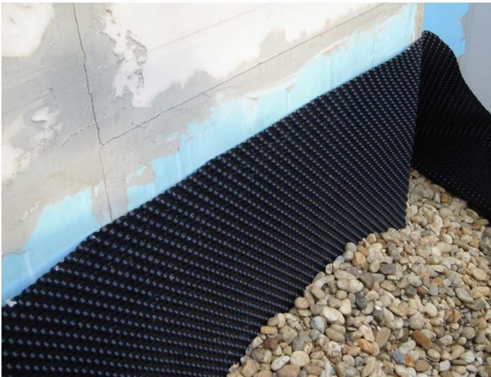
**Abbildung 6:** richtige Verlegung der Noppenbahnen (Noppen nach außen)
