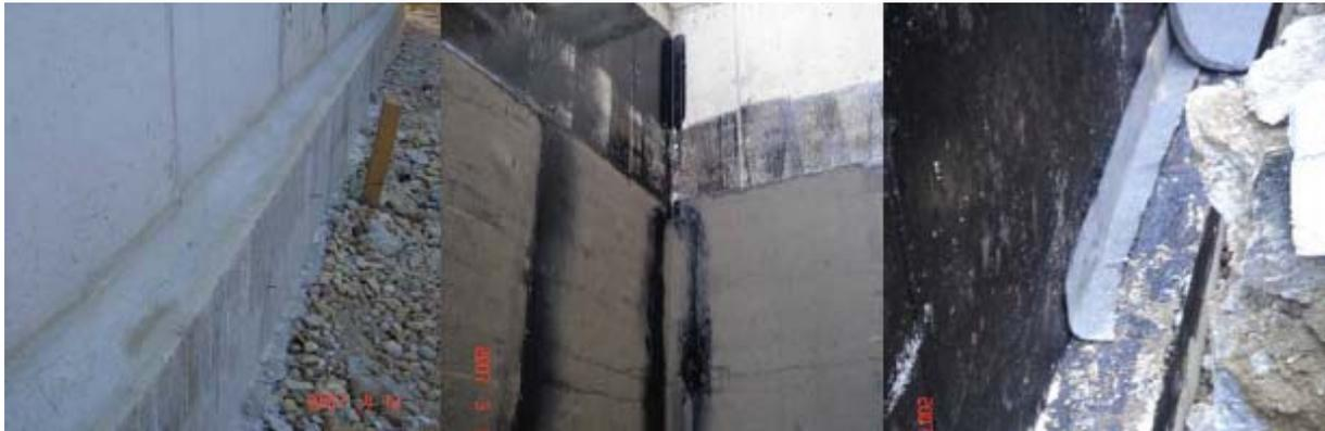
**Abbildung 3:** Bild links: Hohlkehle; Bild Mitte: Verstärkungsstreifen lotrecht; Bild rechts: Verstärkungsstreifen waagrecht.
