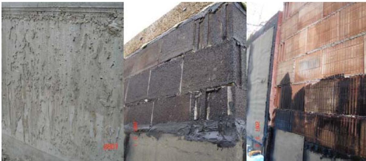
**Abbildung 1:** Bild links: zu raue Betonoberfläche → Glattstrich erforderlich; Bild Mitte und rechts: Schalsteinmauerwerk, Ziegelmauerwerk → Verschließen der Fugen und Zementverputz im Eckbereich erforderlich.
