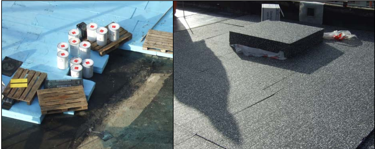
Abbildung 15: Wärmedämmschichten, links Umkehrdach, rechts: Warmdach
