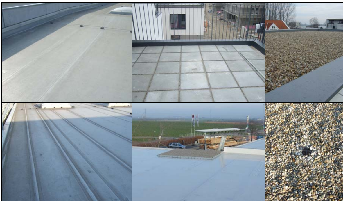
Abbildung 25: Schutz- und Nutzschichten
