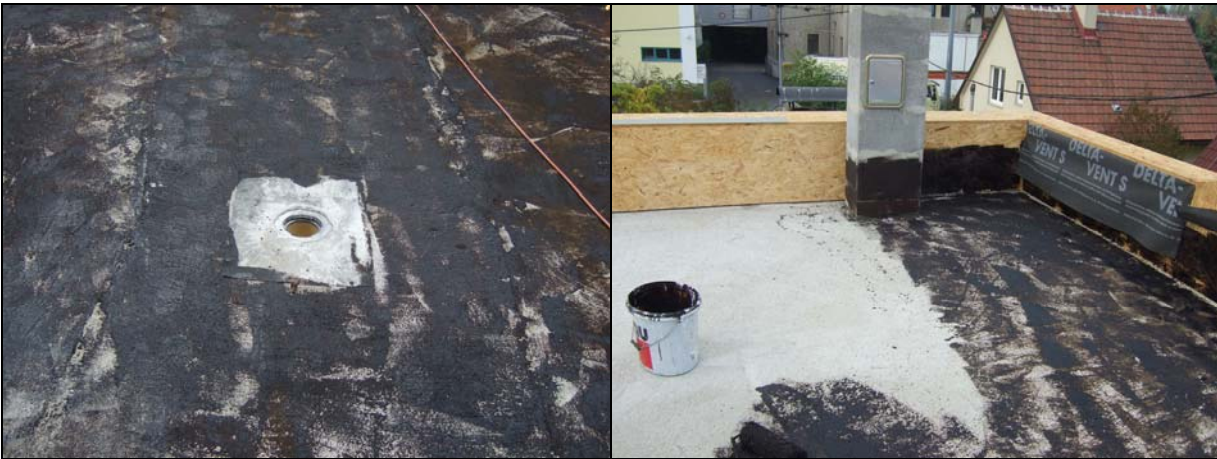
Abbildung 13: Voranstriche, teilweise nicht flächendeckend aufgebracht
