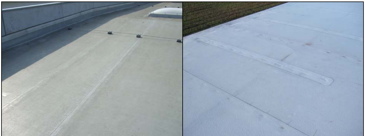
Abbildung 17: Kunststoffbahnenabdichtungen
