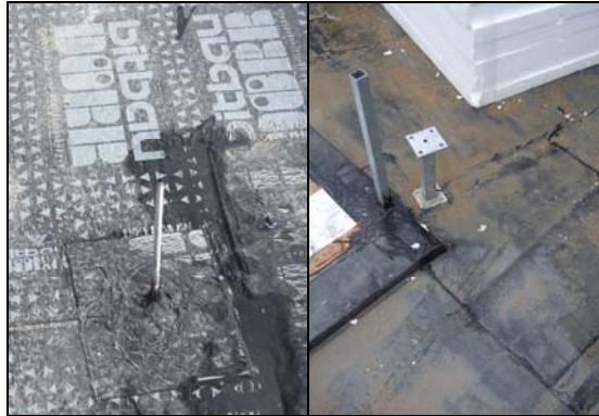
Abbildung 22: Anschlüsse Terrassentrennwände
