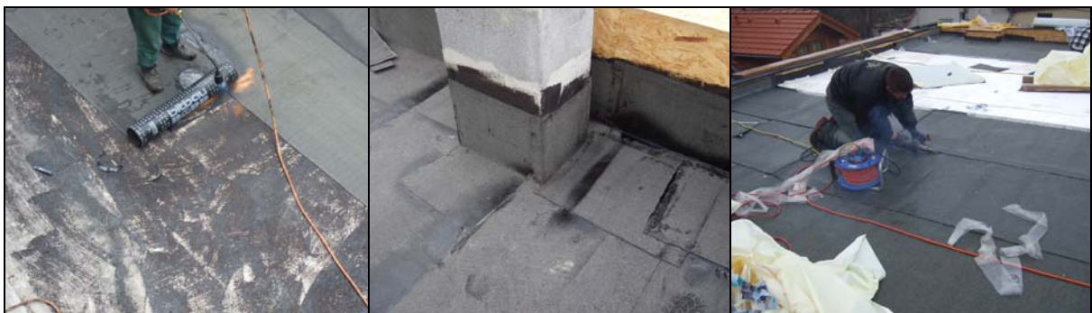
Abbildung 14: Dampfsperrschichten Dampfbremsschichten, Bild links und Mitte Dampfsperre vollflächig verklebt, Bild rechts Ausgleichsschicht streifenweise verklebt.
