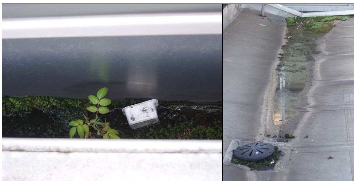
Abbildung 29: unzureichend gewartete Rinne bzw. Flachdach
