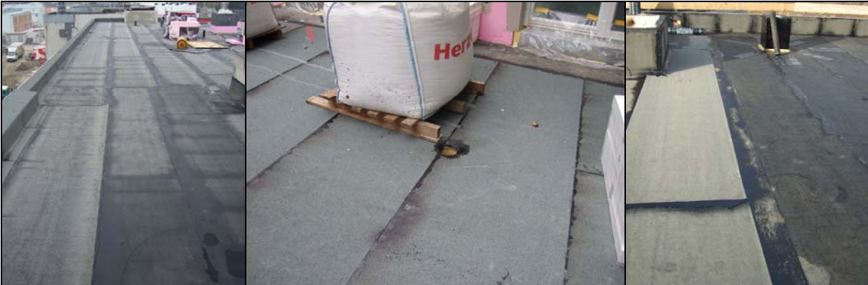
Abbildung 16: bituminöse Abdichtungen
