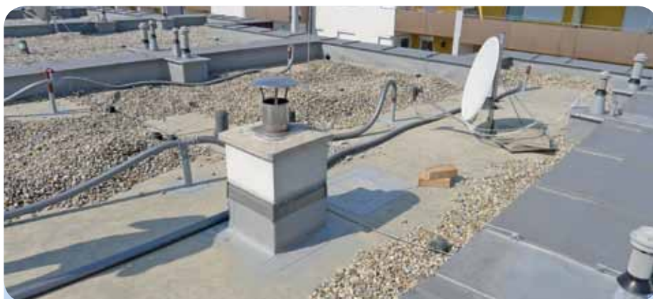
Bei diesem Flachdach findet die Trocknung mittels warmer, trockener Luft statt.
