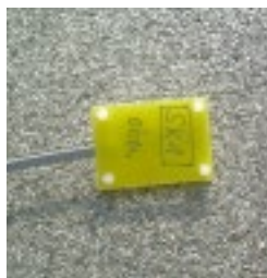
↑ ↑ Eingebaute Sensoren mit Leitungsführung aus dem Dachschichtenaufbau.
