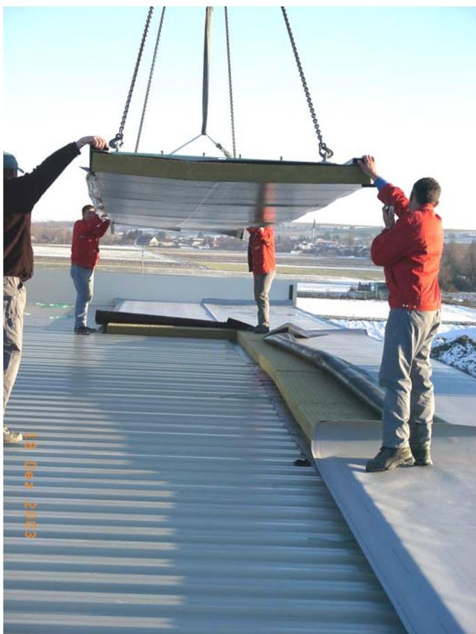
Im Regelfall übernehmen zwei Personen den Heberahmen und positionieren das Dachschichtenelement.
