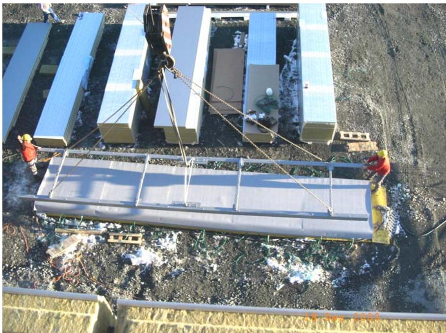
Der Dachschichtenkomplex fixiert im Heberahmen am Weg auf das Dach.
