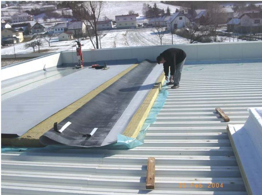
Detailansicht: Dachbahnenüberstand, der materialspezifisch verschweißt wird. Unterhalb der WD ist die Dampfbremse angeordnet, die mit doppelseitigen Klebeband untereinander verklebt werden.
