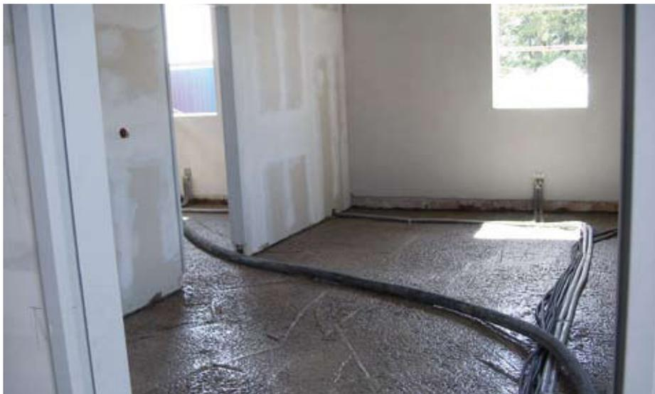
**Bauschaden:** Eine falsche Ausführung – wie im Bild zu sehen. Hier ist der Untergrund zu uneben für eine Epoxid-Innenabdichtung. Das kann zu fatalen Folgen führen.
