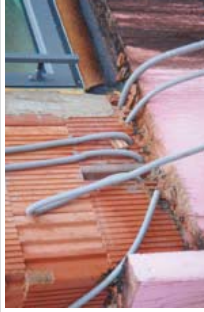
Falsch: Elektroschlüuche im Abrochtungsniveau.
