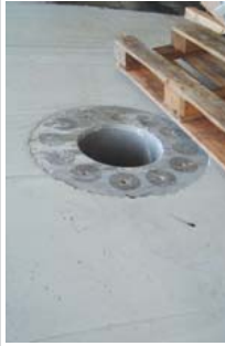
Richtig: Festsitzflansch in Betonwand bei Druckwasser.
