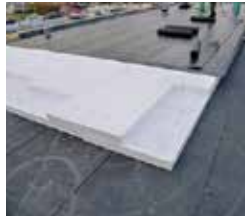
Vorbereitung der Wärmedämmung zur Abschottung.
