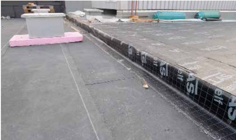
Abschottung mit Abdichtungsbahn.
