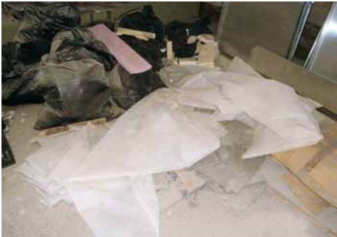
Bauschutzabdichtung ist keine Reststofflagerfläche.
