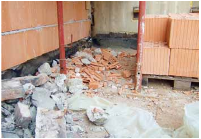
Eine permanente Ergänzung ist erforderlich.
