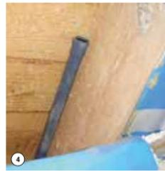
Die zweilagig verlegte Glaswollendämmung wurde ausgebaut, und es war gleich deutlich starke Zugluft zu verspüren. Ein Polokalrohr, das über die Terrassentwässerung geführt wurde, kam zum Vorschein (Bild 4).
