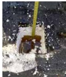
Akuter Handlungsbedarf: Das Wasser im Dachaufbau steht bereits rund zwölf Millimeter hoch.
