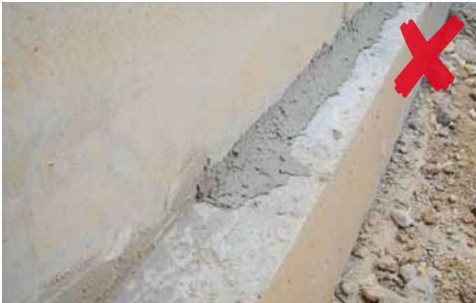
FALSCH: Eine Hohlkehle, die nicht als Hohlkehle funktioniert, da die Oberflächenrauigkeit und die Schichtdicke unregelmäßig ausgeführt sind. So kann sie nicht das leisten, wofür sie gebaut ist.
