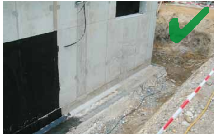
RICHTIG: Eine sauber ausgeführte Hohlkehle ist bei einem rückläufigen Stoß erkennbar. Das ausführende Unternehmen hat eine Erleichterung bei der Verarbeitung und kann die Polymerbitumenbahnen sicher applizieren.
