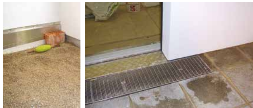
Korrekte Ausführung: Splittschüttung und Drainagebahn.
