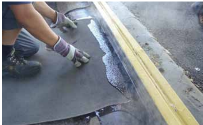
Bituminöser Anschluss an die Belagsdehnfuge
