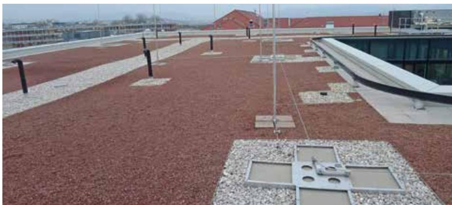
*Ein schwerer Oberflächenschutz übernimmt mehrere Funktionen, neben dem mechanischen Schutz, dem thermischen Schutz oder dem Brandschutz auch den Schallschutz.*
