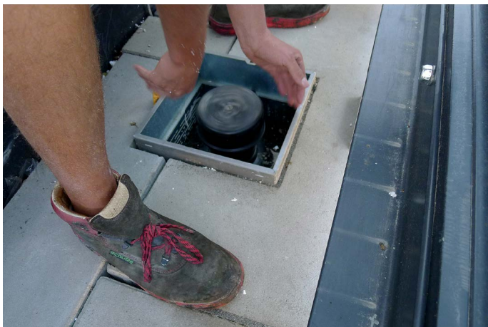
Abb. 2: Einbringöffnung in einer genutzten Dachfläche für Feuchtesensoren.
