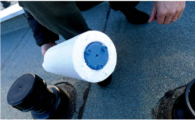
Abb. 4: Damit keine Wärmebrücken entstehen war das Sensorgehäuse im Wärmedämmzylinder eingepasst worden.
