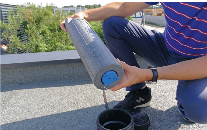
Abb. 5: Über Inspektionsöffnungen, welche in die Dachabdichtung eingedichtet sind, werden wärmedämmte Sensoren in den Dachaufbau versenkt.
