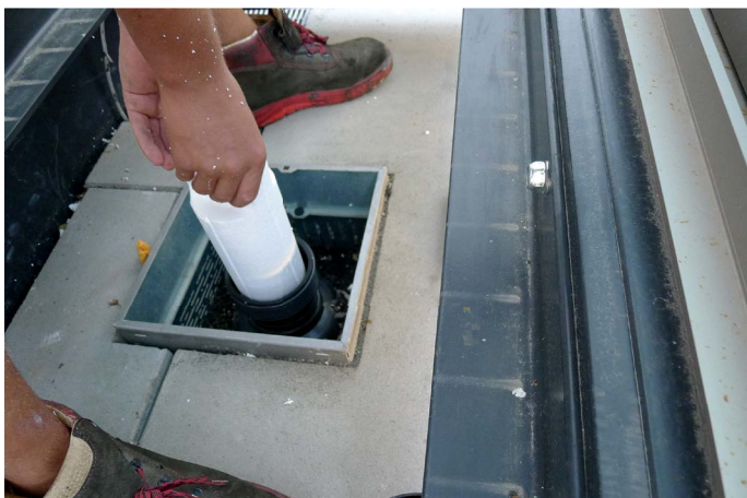
Abb. 3: Der Feuchtesensor wurde am Tief- punkt des Dachaufbaus positioniert.
