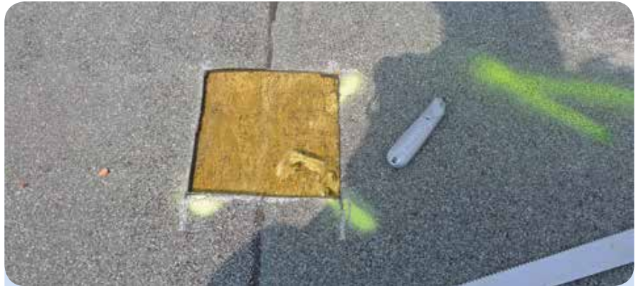
Lose verlegte mehrschichtige aber einlagige Abdichtungsbahn.
