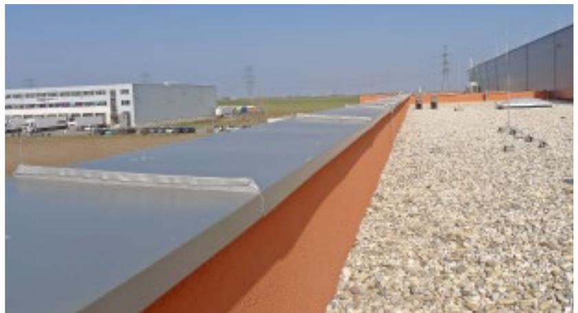
Attiken benötigen einen dauerhaften Witterungsschutz in Form von Abdichtungshochzügen und Abschlüssen, die durch Attikaverblechungen geschützt werden sollten.
