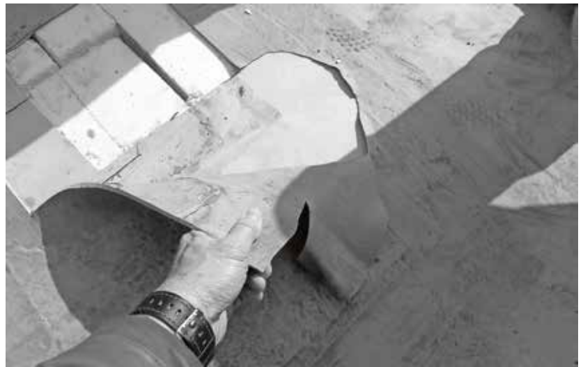
Geringe Haftabzugsfestigkeit zwischen Flüssigkunststoff und Kunststoffdachbahn.
