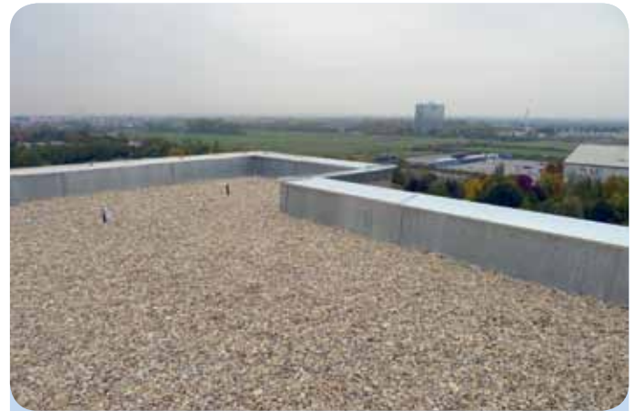
Um die Suche nach der Fehlstelle am Hallendach zu beschleunigen, können Leckortungsdetektoren eingesetzt werden.
