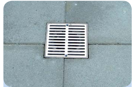
Wichtig ist die regelmäßige Reinigung von zugänglichen Terrassenentwässerungsabläufen, wie es hier gemacht wurde.
