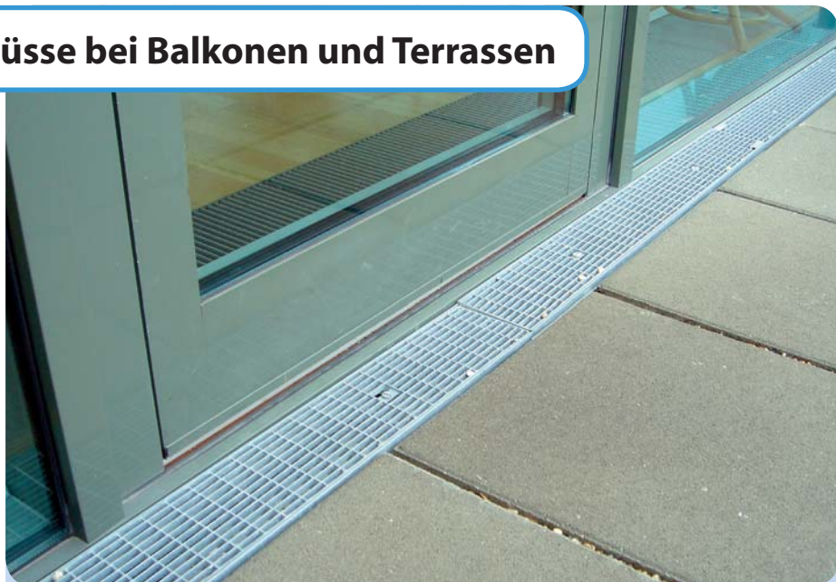
Hier sieht man einem mit Rigol sauber ausgeführten Terrassentüranschluß.
