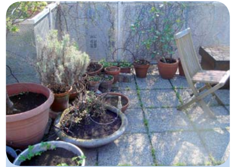
Eine fachgerechte Wartung und Reinigung hätte die Funktionstauglichkeit dieser Terrassenfläche sicherlich verlängert.
